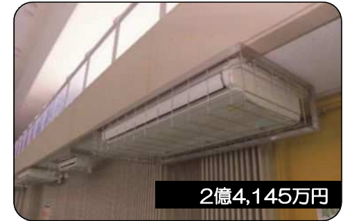
総合体育館空調整備
